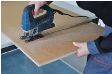
Резку звукоизоляционных панелей производить в горизонтальной плоскости электролобзиком, отрезной машиной или ножовкой по дереву.
