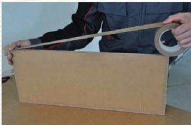
После резки панель повернуть срезом вверх и место «среза» проклеить клейкой лентой Wolf Tape.
