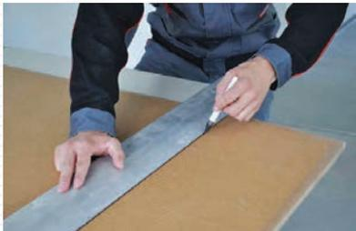
Разметка звукоизоляционных панелей PhoneStar перед резкой.
